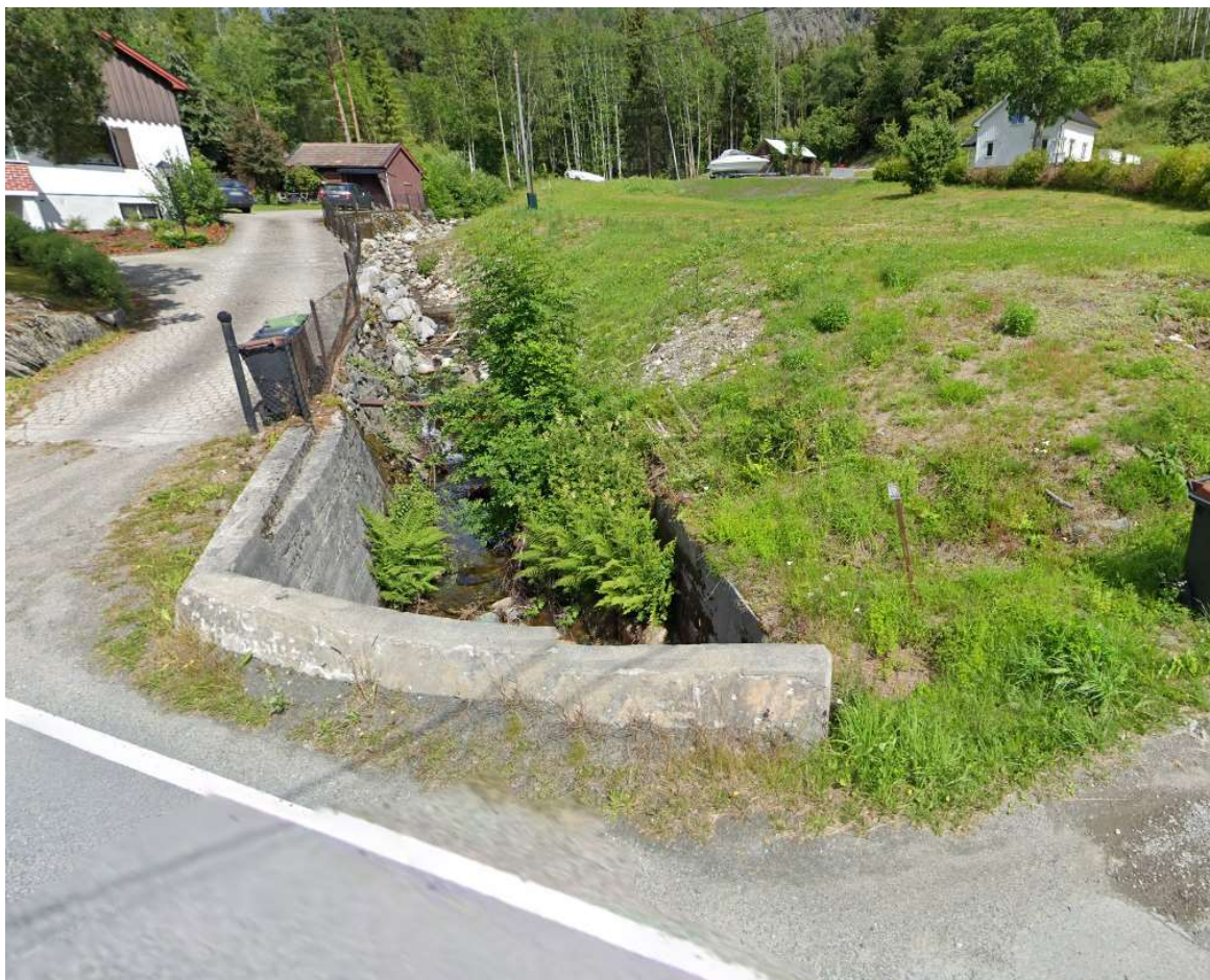
Bilde 1: Bildet viser dagens løsning på nordsiden av rv. 41. Bildet er hentet fra Google map.
