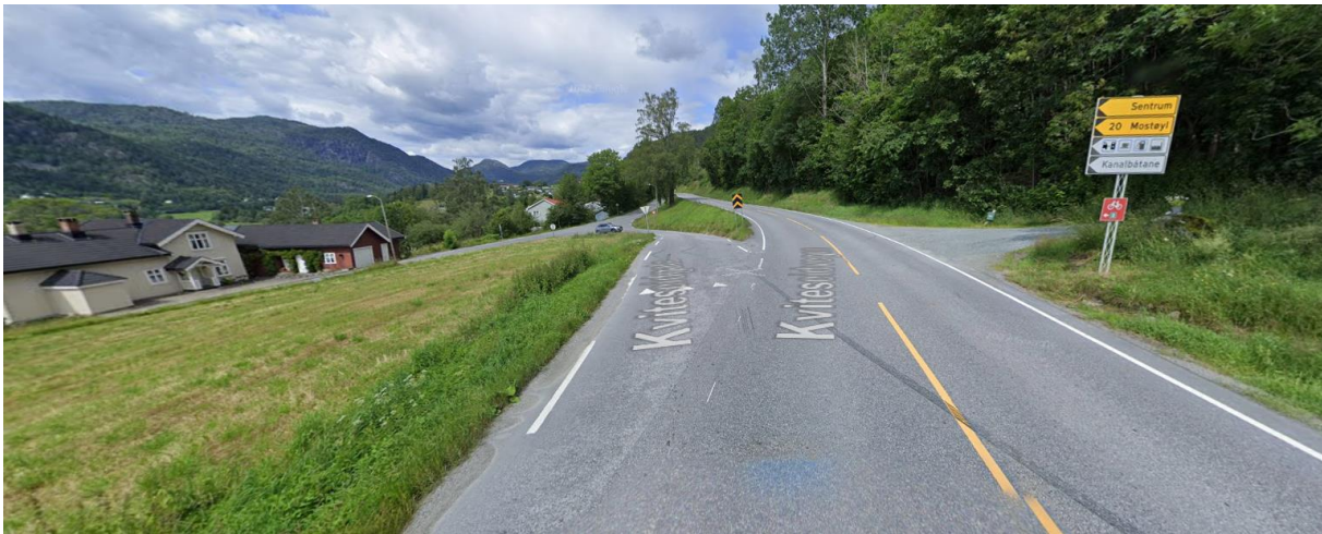
Figur 6. Krysset ned til sentrum, frå sør. Løysninga er uoversiktleg og har ført til fleire samanstyrt. (Foto: Google maps).
