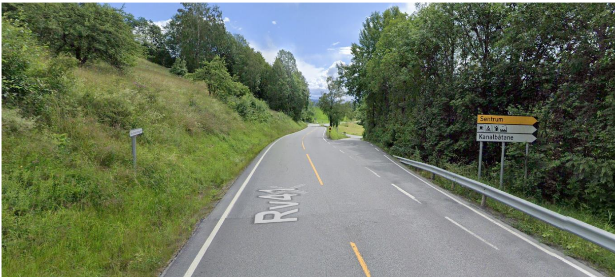
Figur 7. Krysset ned til sentrum, frå nord. (Foto: Google maps).
