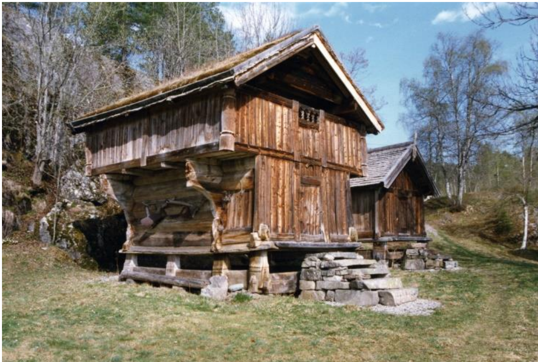
Sandland, søndre. Loft på underbunad. Høgovalt tømmer i begge høgder. Svalgang i front 1. høgde, i 2. høgde rundt hele huset - med staver, sviller og veggtiler. Tømra røst i gavlene på svalgangene. Taket tekt med never og torv.(Askeladden)
